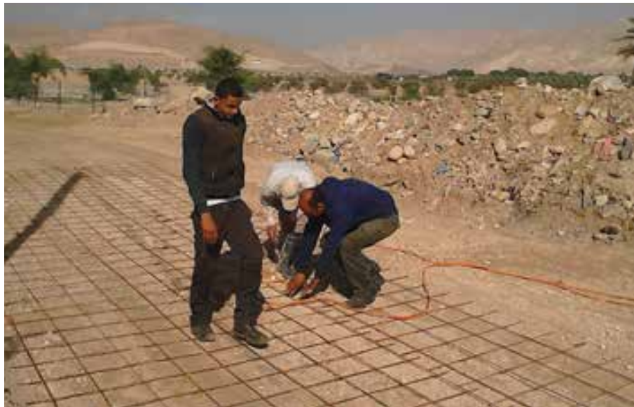
Renforcement de la route avant bétonnage
