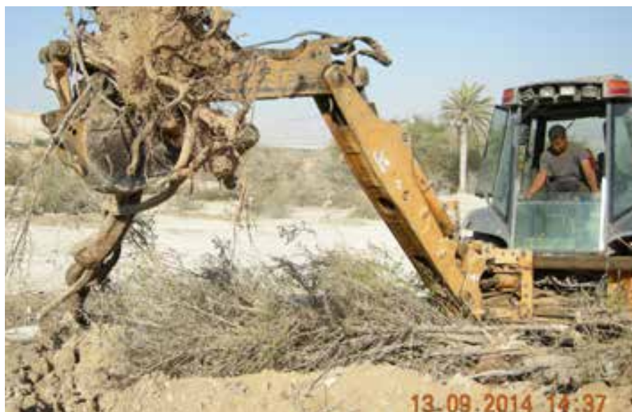
Arrachage des souches avant la pose du grillage et les plantations
