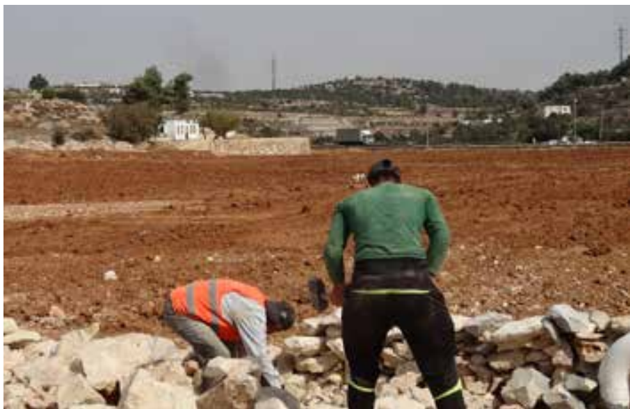
Vue du champ en fin de chantier, la route 60 au fond
